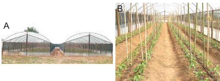
Figura 8. Estufas agrícolas do tipo arco: vista externa (A) e vista interna com pimentão (B). Fotos: Edson Akira Kariya (Itapetininga, SP).
