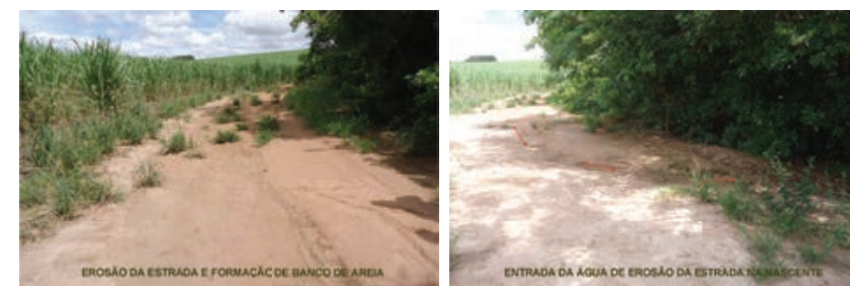
Figura 11. Erosão da estrada e formação de banco de areia. Entrada da água de erosão da estrada na nascente.
