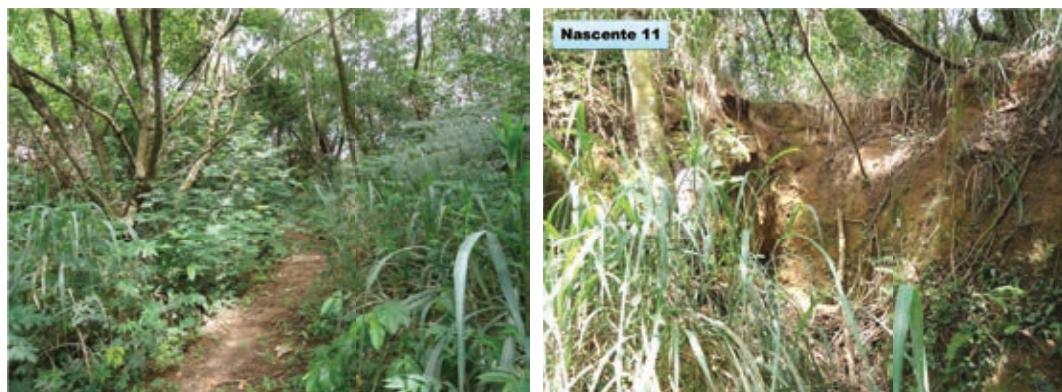
Figura 12. Trilhas formadas dentro da APP da nascente. Nascente já transformada em voçoroca em razão da entrada da água erosiva vinda da estrada.
