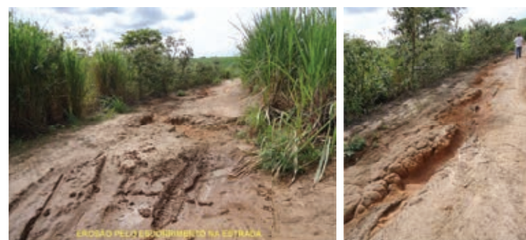
Figura 8. Erosão pelo escoamento de água na estrada de contorno da nascente.
