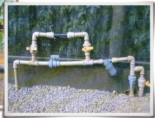
Figura 5. Detalhe do venturi - injetor de fertilizantes.
