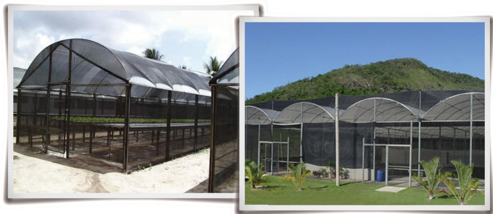
Figura 1. Modelos de estruturas tipo arco simples e conjugada.
