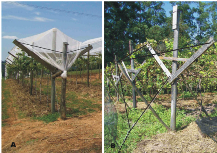
Figura 18. Ancoragem utilizando mourão, travessa de madeira e cabo esticador (A) e, utilizando âncora, travessa de madeira e cabos esticadores destacados para melhor visualização (B).
