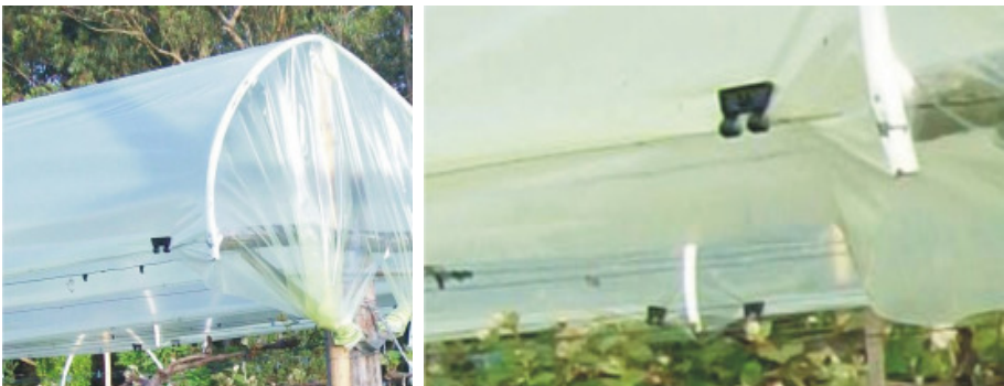
Figura 9. Detalhe da fixação do plástico nas cabeceiras e nas laterais do sistema de sustentação.
